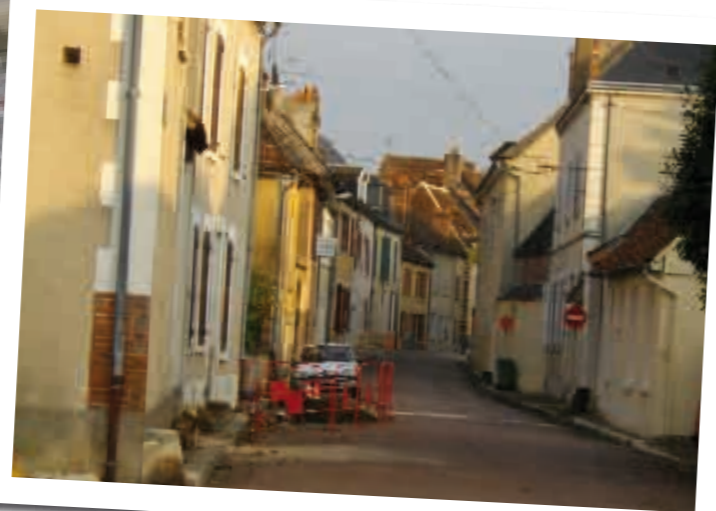
Nouveau chantier rue Saint Martin
